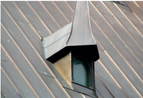
Dach aus Zinkblech
